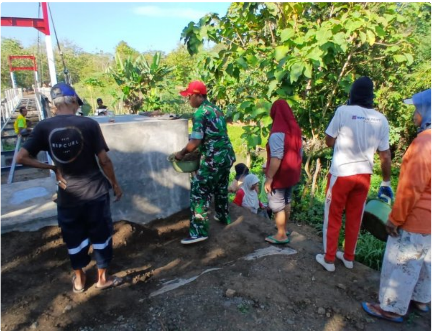
Warga Dan TNI Gotong Royong Ratakan Jalan Menuju Jembatan Garuda Di Karangpaket
