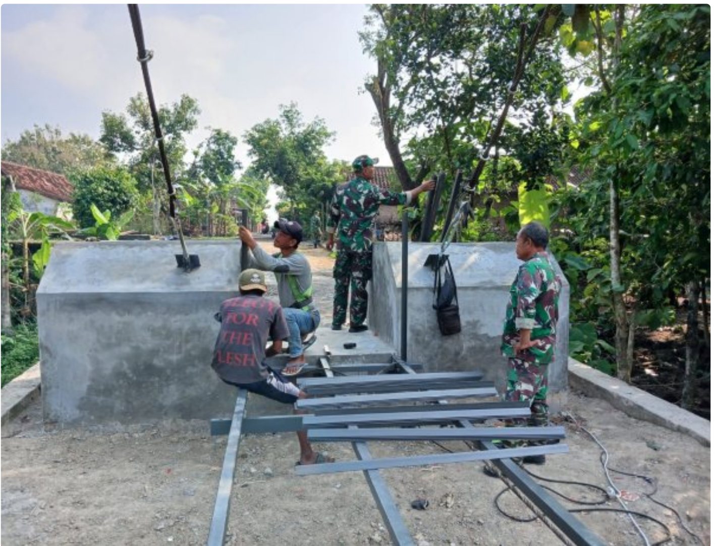
Sinergi TNI dan Warga Warnai Pemasangan Railing Jembatan Gantung Garuda Karangpapel
