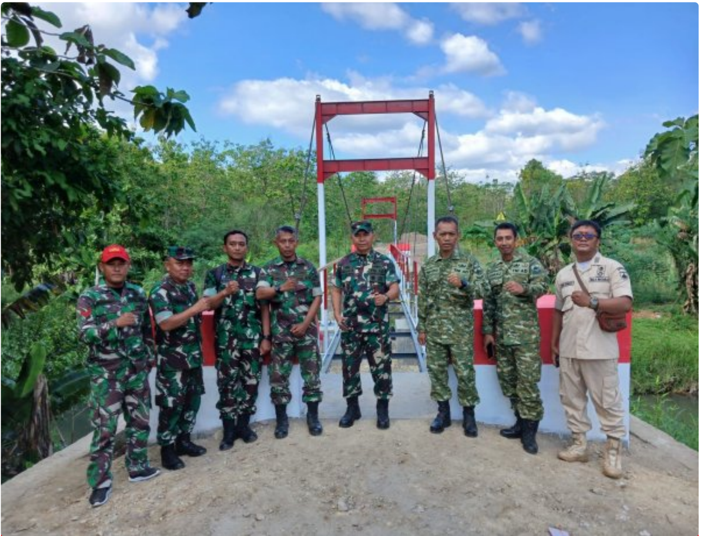
Sinergi TNI Dalam Pembangunan Wilayah, Dandenzibang Surakarta Tinjau Jembatan Garuda
