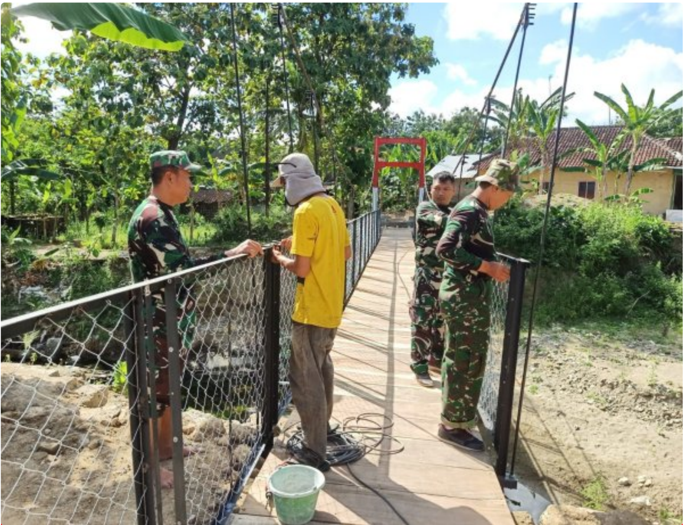
Pembangunan Jembatan Gantung Garuda Bayat, Masuki Tahap Pemasangan Pengaman
