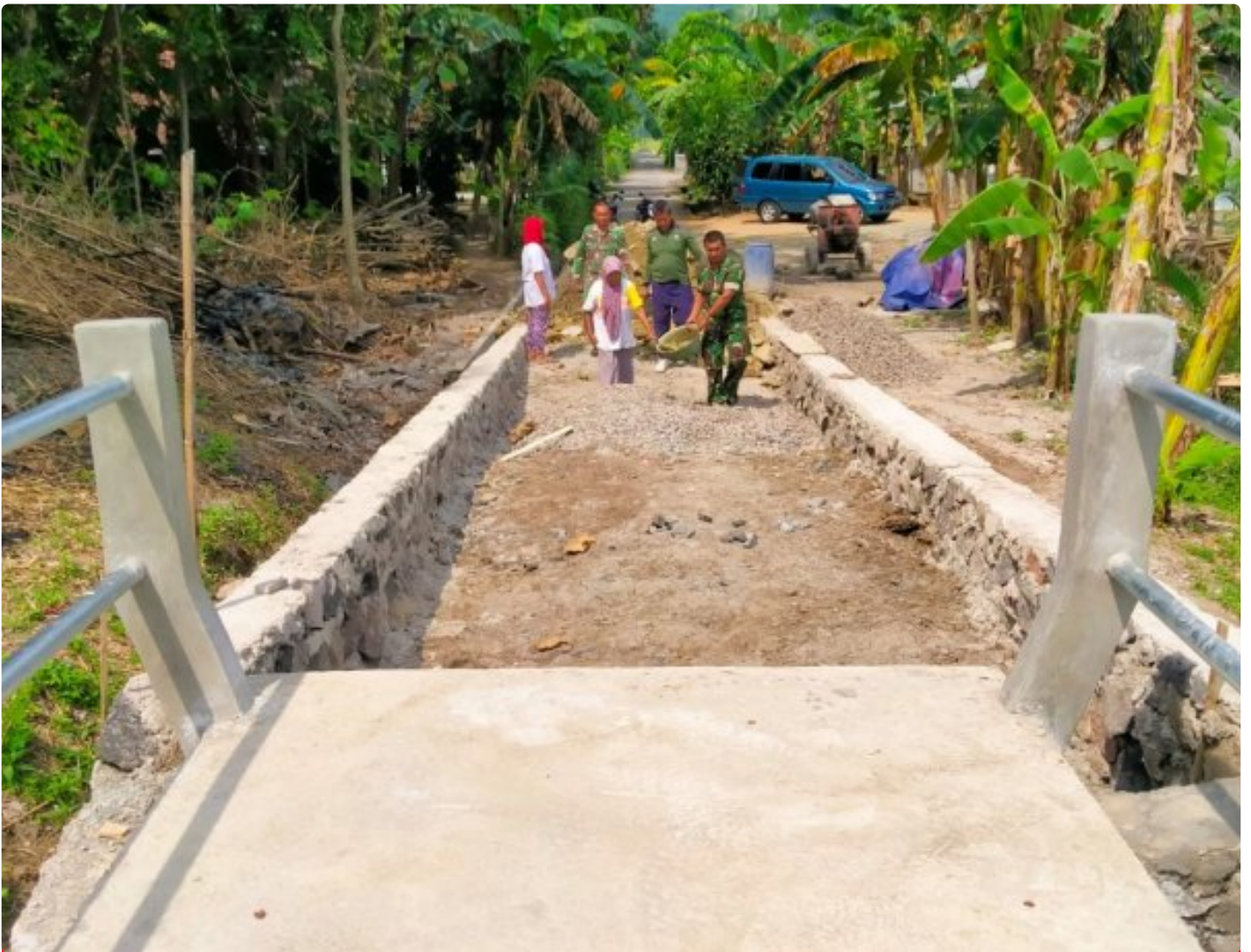
Ibu-Ibu Desa Burikan Turun Tangan Ratakan Urug Jalan Menuju Jembatan Garuda Bersama TNI
