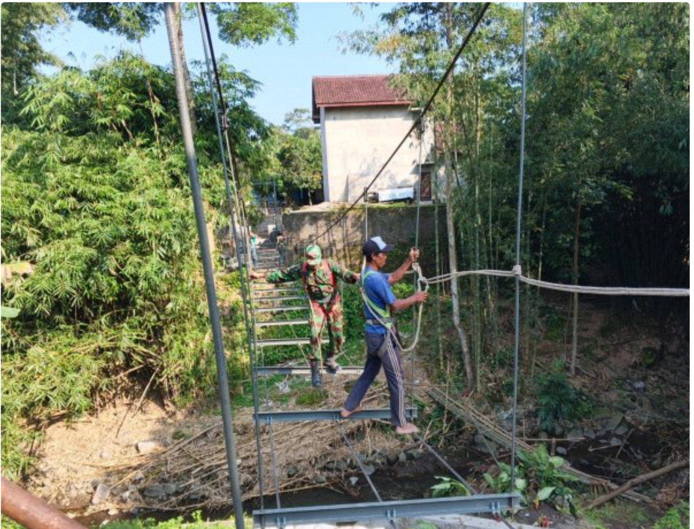
Babinsa Koramil 12/Manisrenggo Turun Langsung Bantu Pengerjaan Jembatan Gantung Garuda
